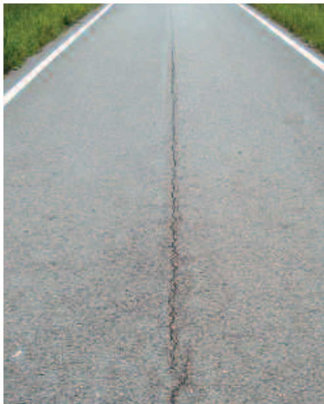
Foto 2.7 Visione d'insieme di un tratto di pavimentazione armata con fibre di vetro. La lesione longitudinale centrale copre l'intero tratto.
