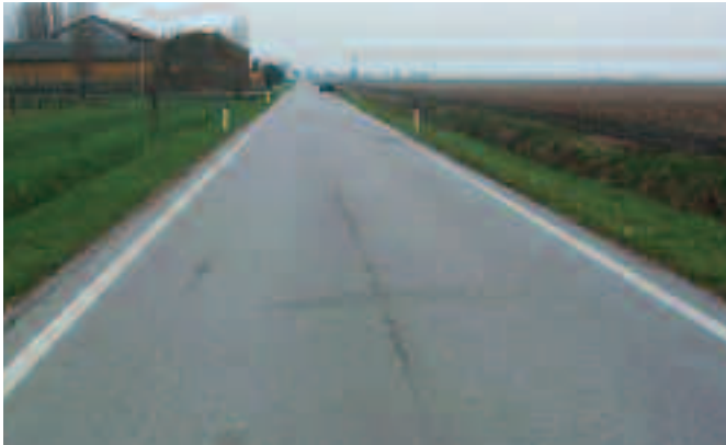
Foto 2.1 Aspetto pavimentazione armata con rete in fibra di vetro
