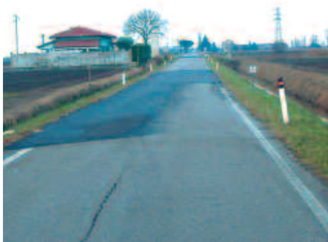
Foto 2.5 Tratto in cui è stato necessario eseguire un nuovo intervento di manutenzione consistente nell'aggiunta di uno strato di asfalto.
