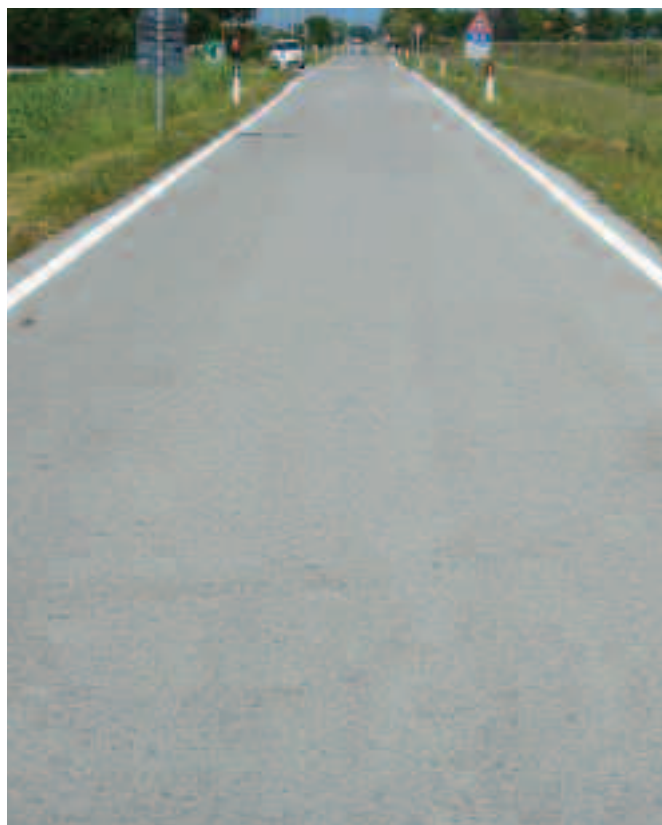
Foto 1.6 Visione di insieme della pavimentazione stradale armata con rete elettrosaldata
