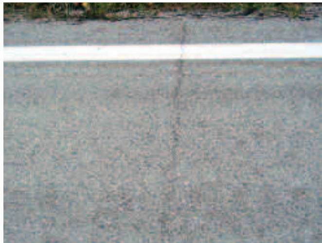
Foto 1.7 Lesioni trasversali provocate probabilmente da una non corretta sovrapposizione dei pannelli di rete elettrosaldata.
