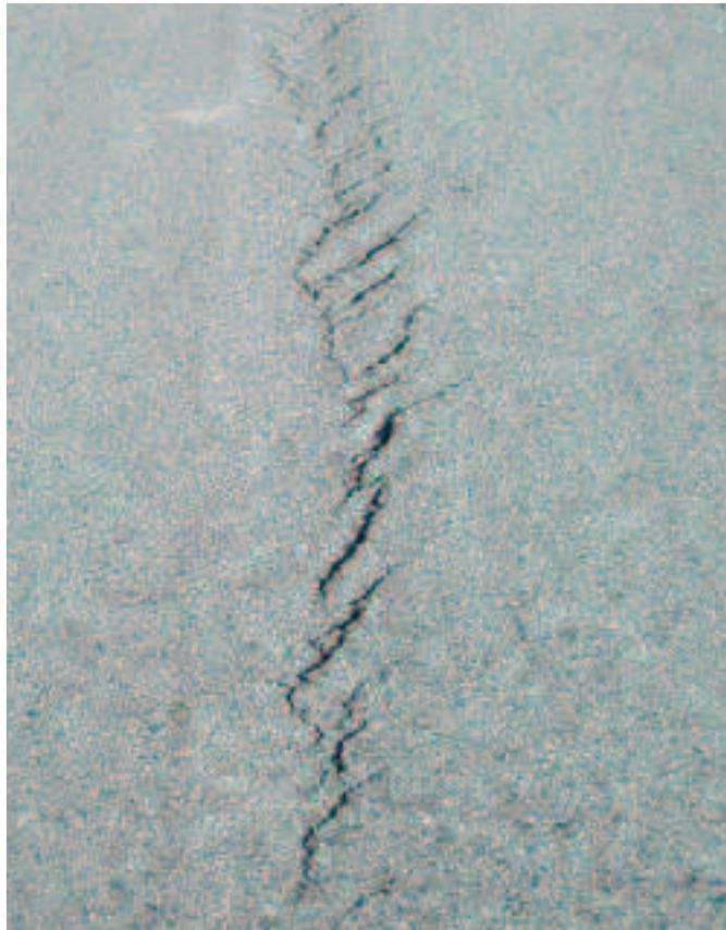
Foto 2.6 Grave lesione nel centro di una corsia, in prossimità delle zone sottoposte a carico.
