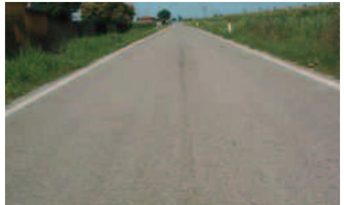
Foto 2.3 Aspetto d'insieme della pavimentazione armata con rete con fibre di vetro
