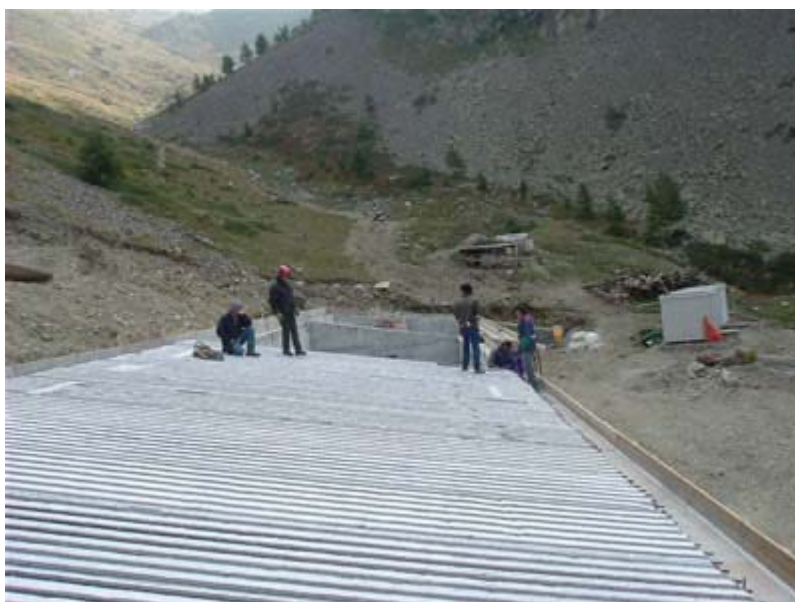
Figura 2. Solaio realizzato in quota
