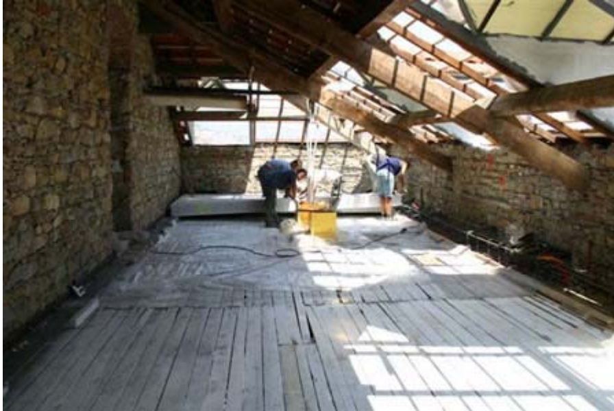
Figura 3. Solaio non puntellato sopra un impalcato esistente
